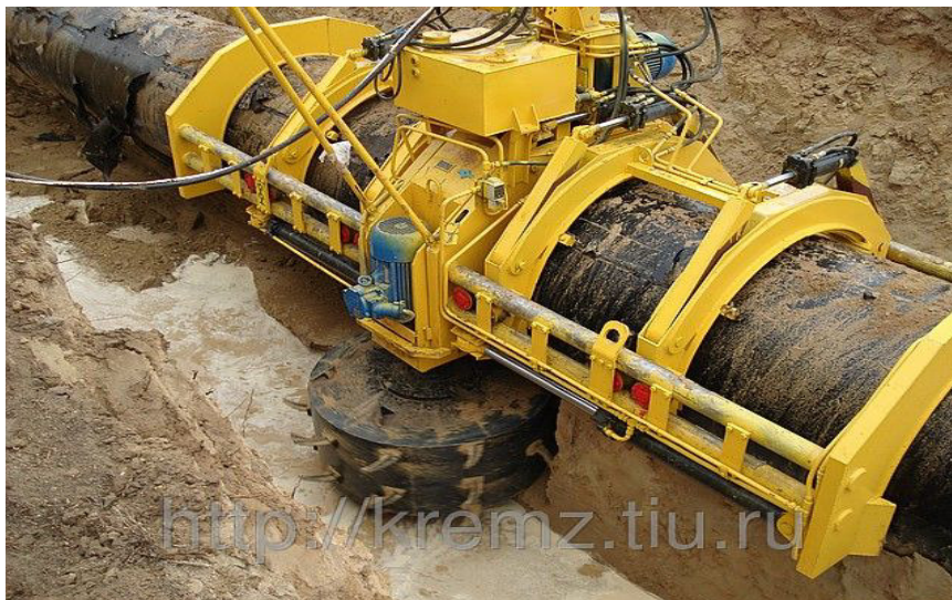
Рисунок 2 – Роторная подкапывающая машина МП-1420
