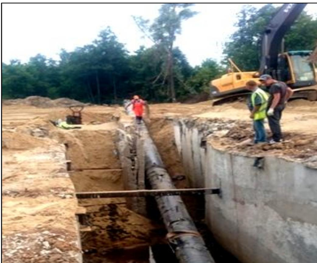
Рисунок 2 – Участок сопряжения двухочковой водопропускной трубы с одноочковой
